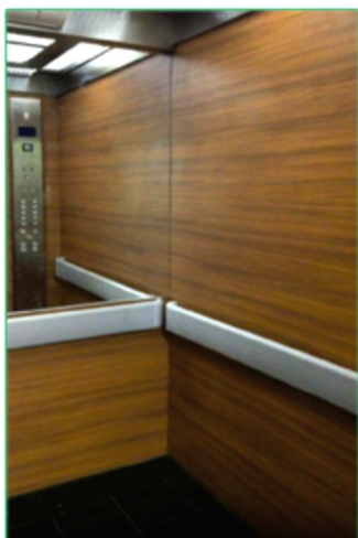
Acabamento em fórmica
