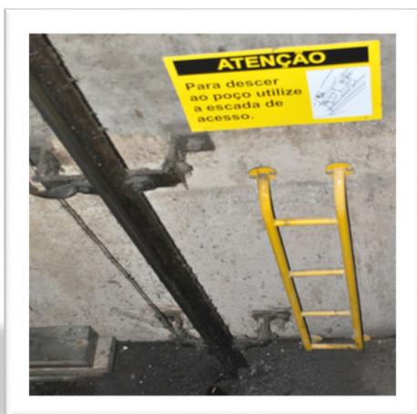
**11. Escada de Marinheiro para o fundo do poço** – Este dispositivo possibilita a entrada do técnico de manutenção no poço, com total segurança, permitindo a execução dos serviços de manutenção nos seus elevadores. **(Atende às exigências da Norma NBR NM207/1999 item 5.7.2.2).**
