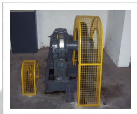
**9. Protetor da polia de tração** – Para proteger que as pessoas autorizadas ao acesso à casa de máquinas não tenham contato com as partes móveis da máquina (polias e cabos de aço), evitando acidentes. **(Atende às exigências da Norma NBR NM207/1999 item 9.5.1, Norma de Segurança NR-12 e NR-18).**
